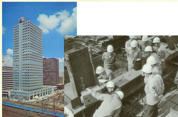
図2 初めて超音波探傷検査が全面的に適用された朝日東海ビル（1971年）
